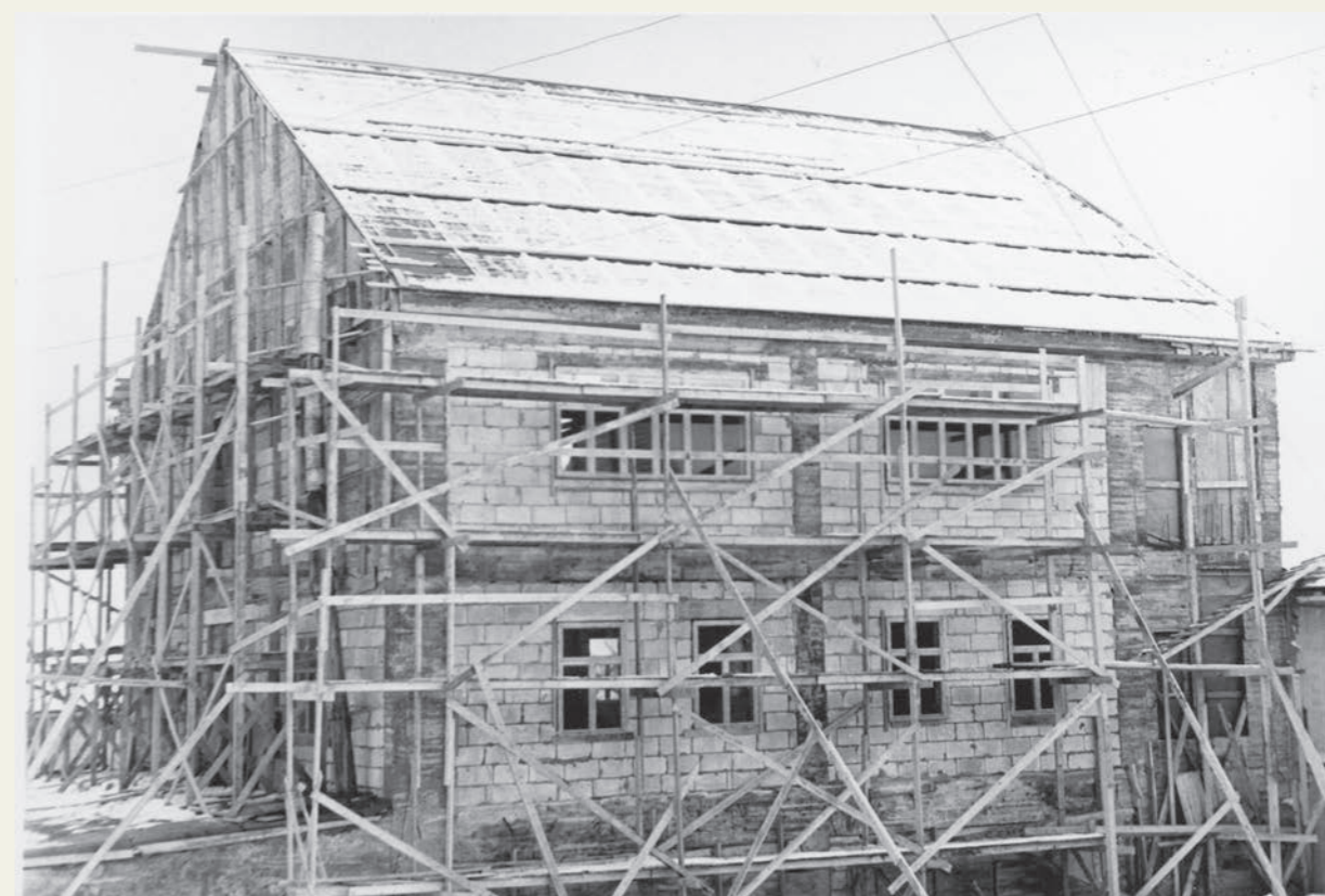
Bygging av den første delen av betongkonstruksjonen. Her ser vi tre etasjer med saltakkonstruksjonen over, som senere ble byttet ut med en til etasje i betong. Foto lånt av Berlevåg havnemuseum, foto Dagbladet Finnmarken
