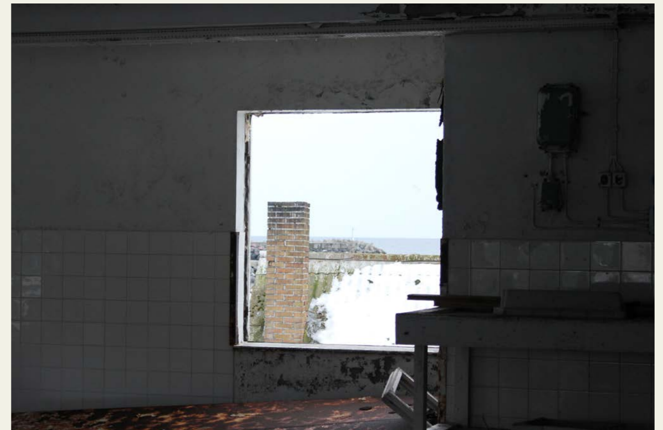
I øverste del av betongbygningen
