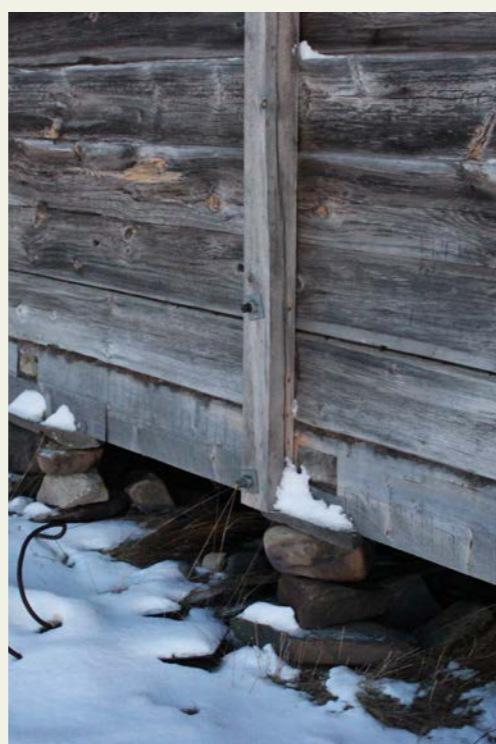
Øverst: lafting med rektangulære tverrsnitt, og torv som isolasjo i fuger Nederst: drivved som kledning holdt fatts av lebord, og stein stablet som fundament
