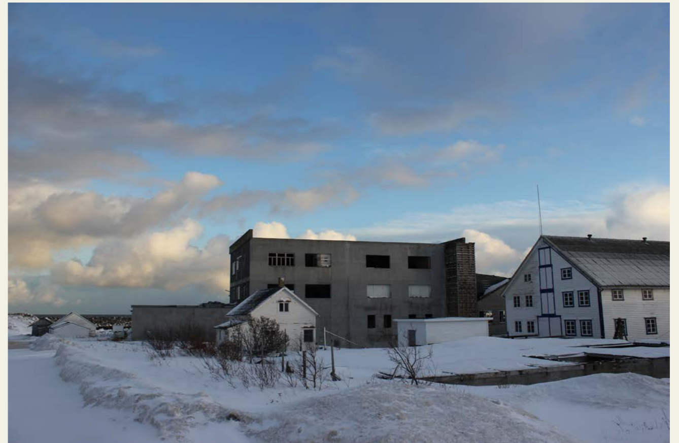
Betongbygningen sett fra Storgata
